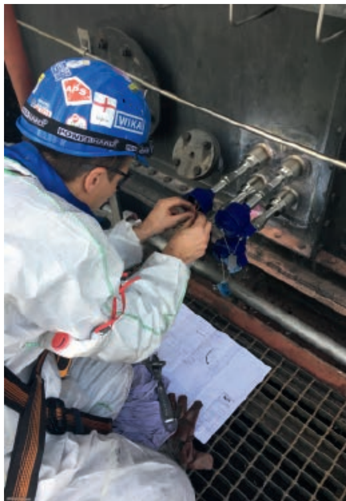
Проверка передачи сигнала и функциональное тестирование
